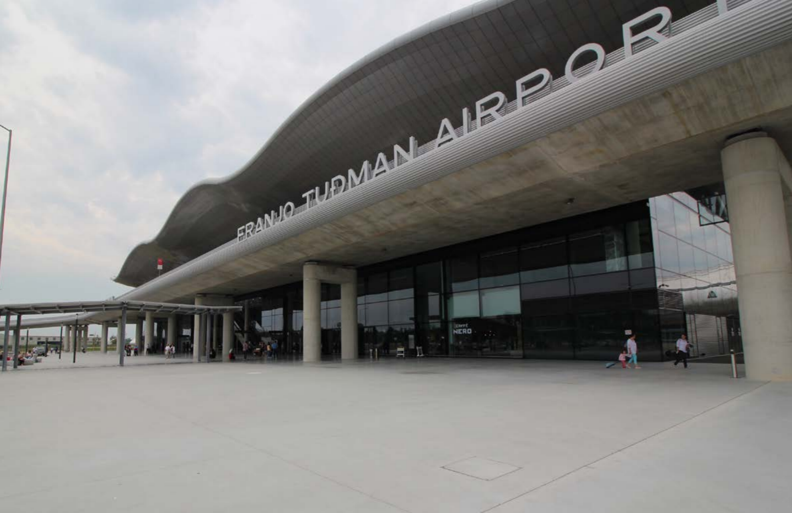
*MEĐUNARODNA ZRAČNA LUKA ZAGREB / vanjski plato armiran sa Fibrofor HighGrade 190 / doziranje 1kg/m3 / 11.000,00 m 2
