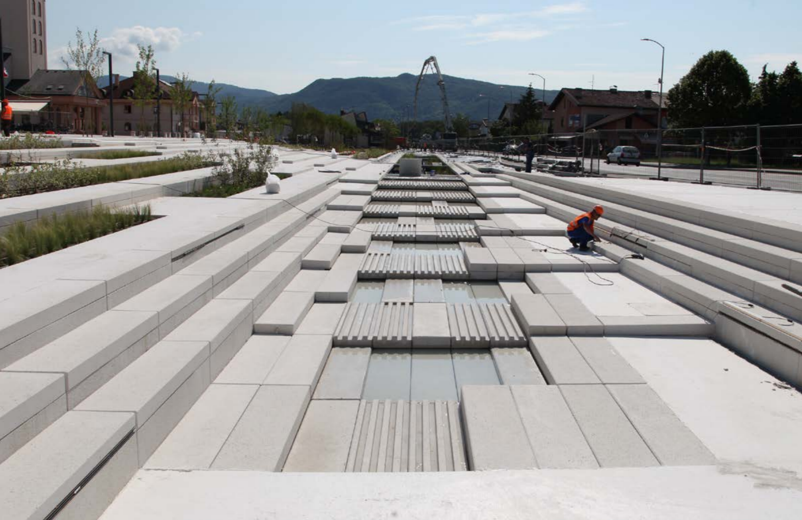
*TRG Dr. FRANJE TUĐMANA, Zaprešić / vanjski plato armiran sa Fibrofor HighGrade 190 / doziranje 1kg/m 3 / 2.500,00 m 2
