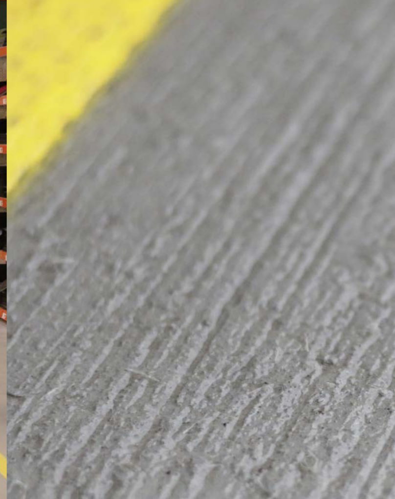
*TC BAUHAUS BUZIN, Zagreb / unutarnja i vanjska podna ploča armirana sa Fibrofor HighGrade 190 / doziranje 1kg/m 3 / 18.000,00 m 2
