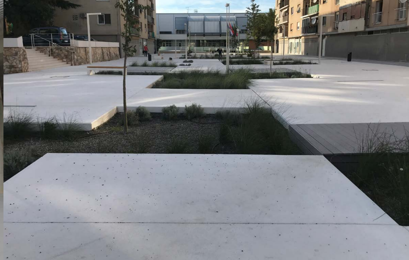
*TRG KRALJA TOMISLAVA, PULA / vanjski plato armiran sa Fibrofor HighGrade 190 / doziranje 1kg/m3 / 5.500,00 m 2
